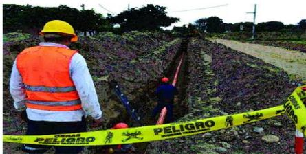
EL PROYECTO CONSIDERA 35 CÁMARAS DE DISTINTOS TIPOS Y 2.354 ml. DE COLECTORES PARA REDES COLECTORAS, 1 SISTEMA DE ELEVACIÓN AGUAS SERVIDAS, 690 ml. DE CAÑERÍAS PARA IMPULSIÓN, OBRAS CIVILES Y MANTENCION OPERACIONES PARA LA HABILITACIÓN DE PLANTA DE TRATAMIENTO DE AGUAS SERVIDAS DEL TIPO LOMBRIFILTRO, OBRAS ELÉCTRICAS Y EMISARIO .
