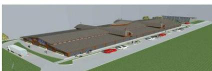
LAS OBRAS CONSIDERAN LA CONSTRUCCIÓN DE UNA ESTRUCTURA METÁLICA TECHADA EN TEJUELA ASFÁLTICA Y REVESTIDA EN MADERA CON LOSA DE HORMIGÓN CON CIERRO EN BASE A CORTINAS METÁLICAS . ESTA ESTARÁ DIVIDIDA EN 168 PUESTOS DE 2.5 x 3.0 mt. INCLUYENDO SUS RESPECTIVAS CIRCULACIONES Y LA DISPOSICIÓN DE SERVICIOS HIGIÉNICOS .
