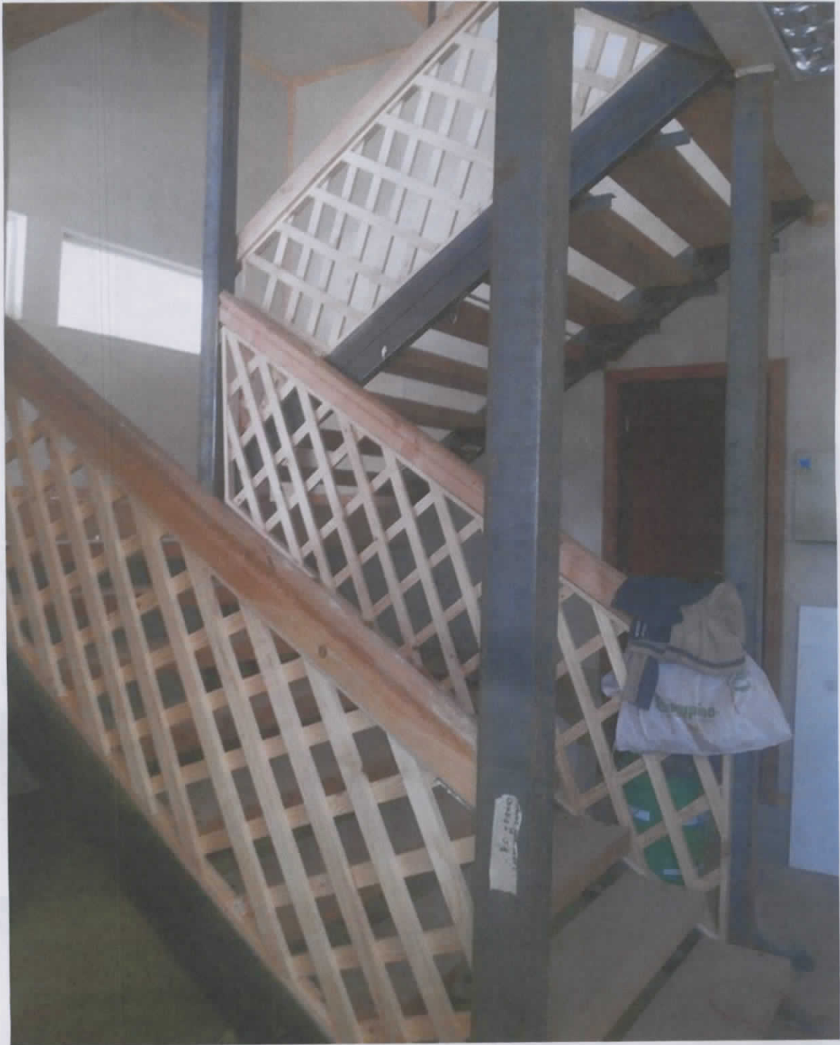
ACCESO SEGUNDO PISO
