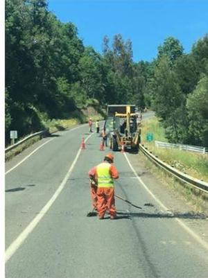
Aquí se ve la gente trabajando, primero se remueve parte de la superficie del pavimento con maquinaria y después se hace todo el procedimiento de enmarcar el bache, imprimir y tirar la mezcla.
