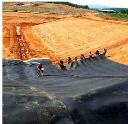
**GEOMEMBRANA DE POLIETILENO DE ALTA DENSIDAD (HDPE).**
