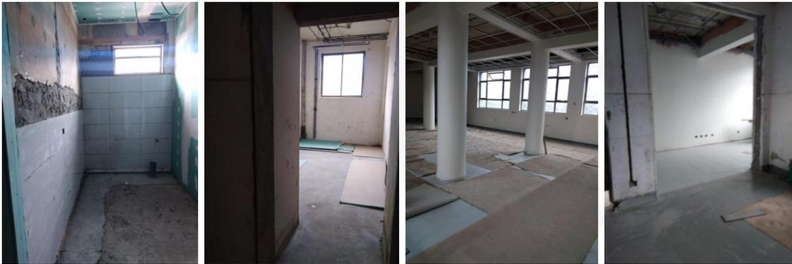
Ustedes pueden ver, por ejemplo, que hay protecciones en el piso, porque el piso ya está terminado, pero, en realidad, todo lo que es la obra gruesa está terminada, y se está empezando lo que es terminaciones, por ejemplo, instalación de cerámicas, muros, etc..
